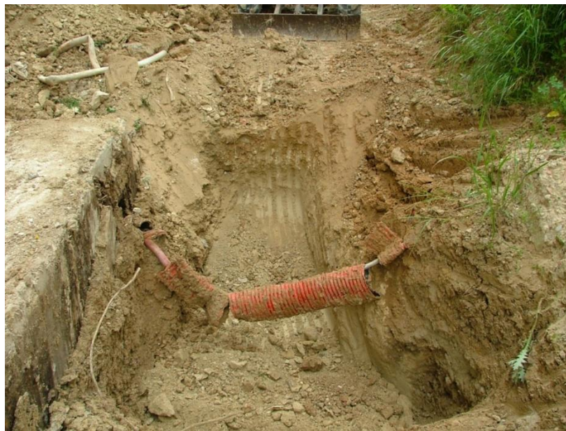
Fig. 3.1.2/E: particolare del pozzetto esplorativo PZ1.
