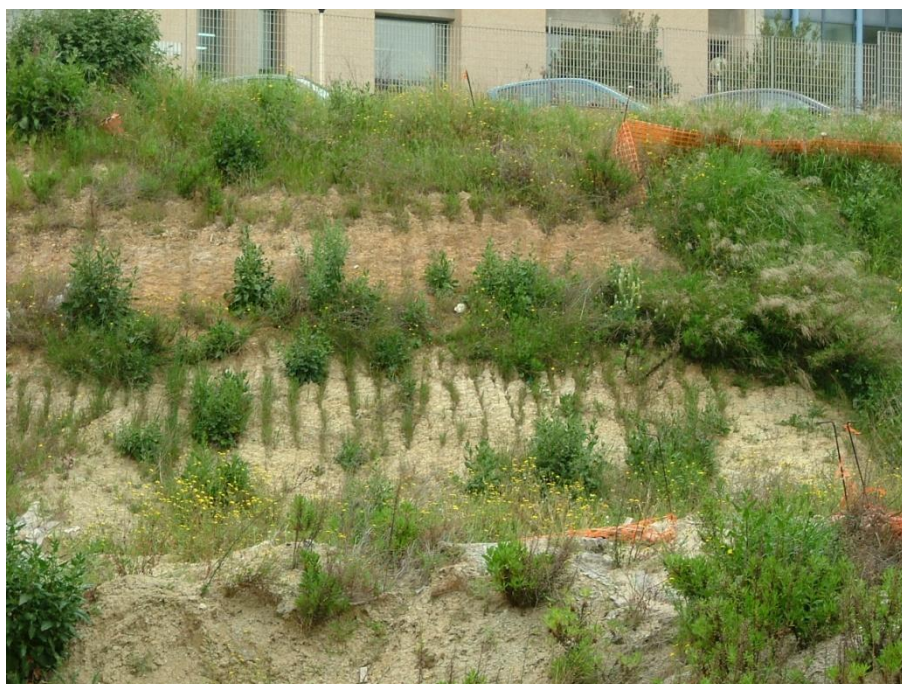
Fig. 3.1.2/A: particolare dei lavori di sbancamento.
